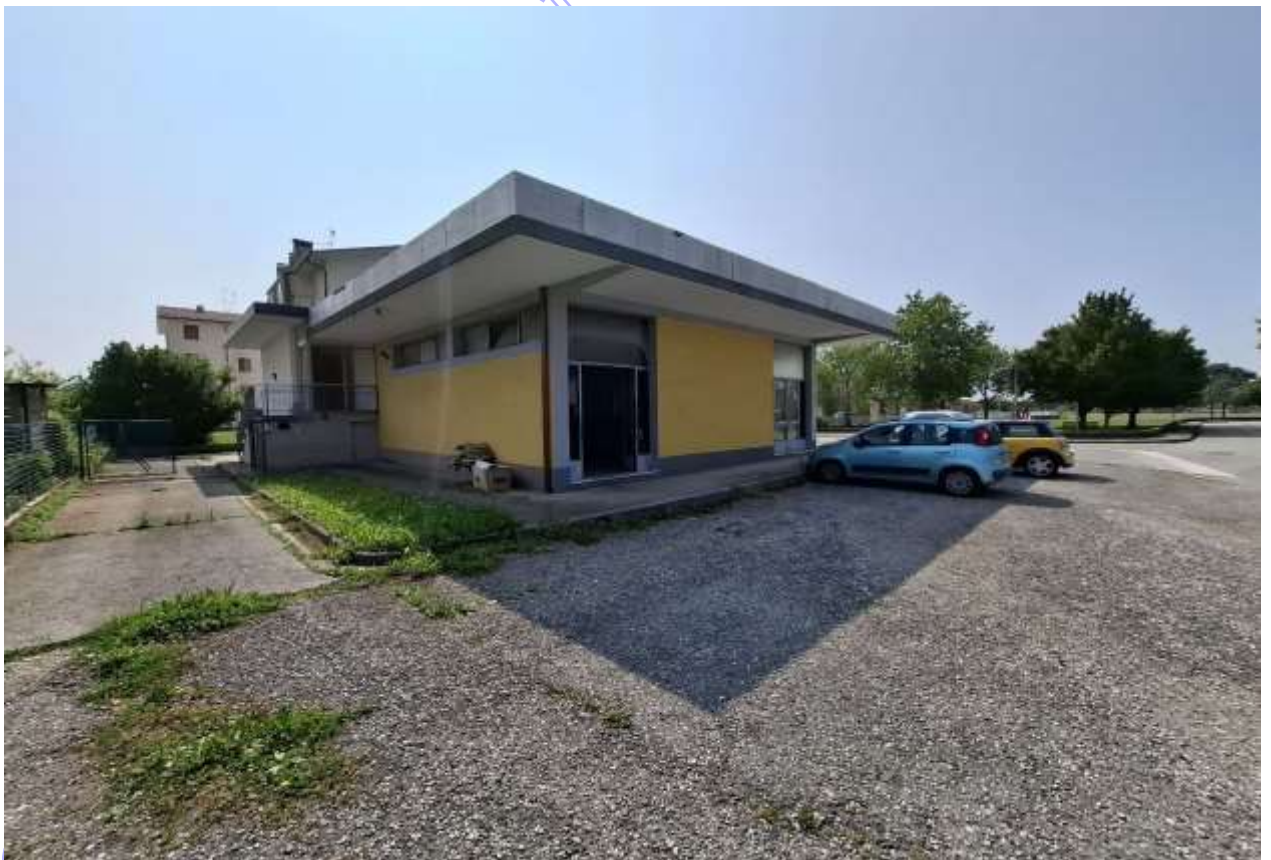
Vista da Via Fortunato
