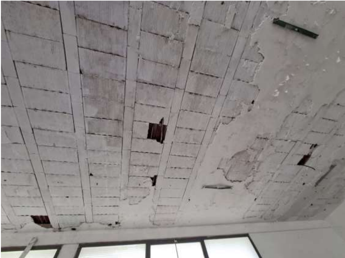
Distacco intonaco con principio di sfaldellamento del solaio
