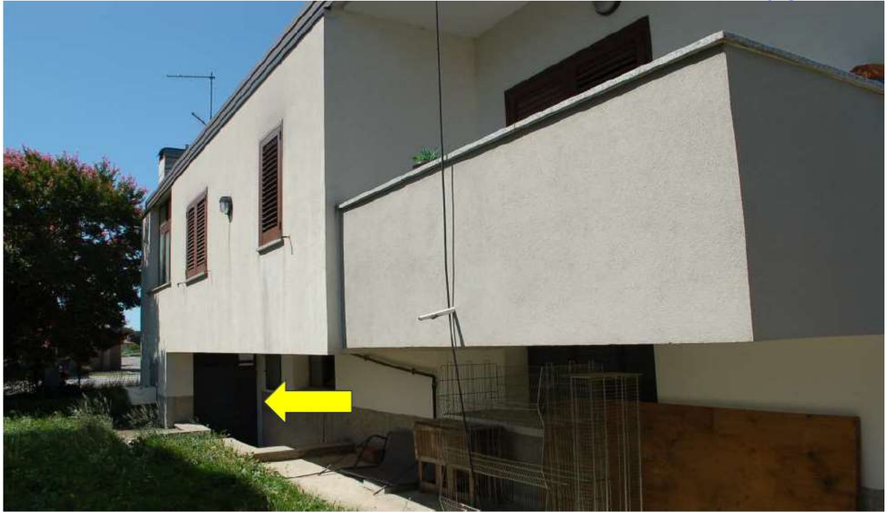
INGRESSO C.T. RETRO Fabbricato
