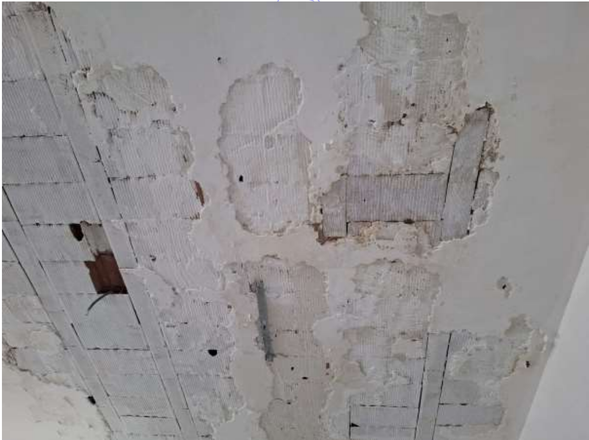
Distacco intonaco con principio di sfaldellamento del solaio
