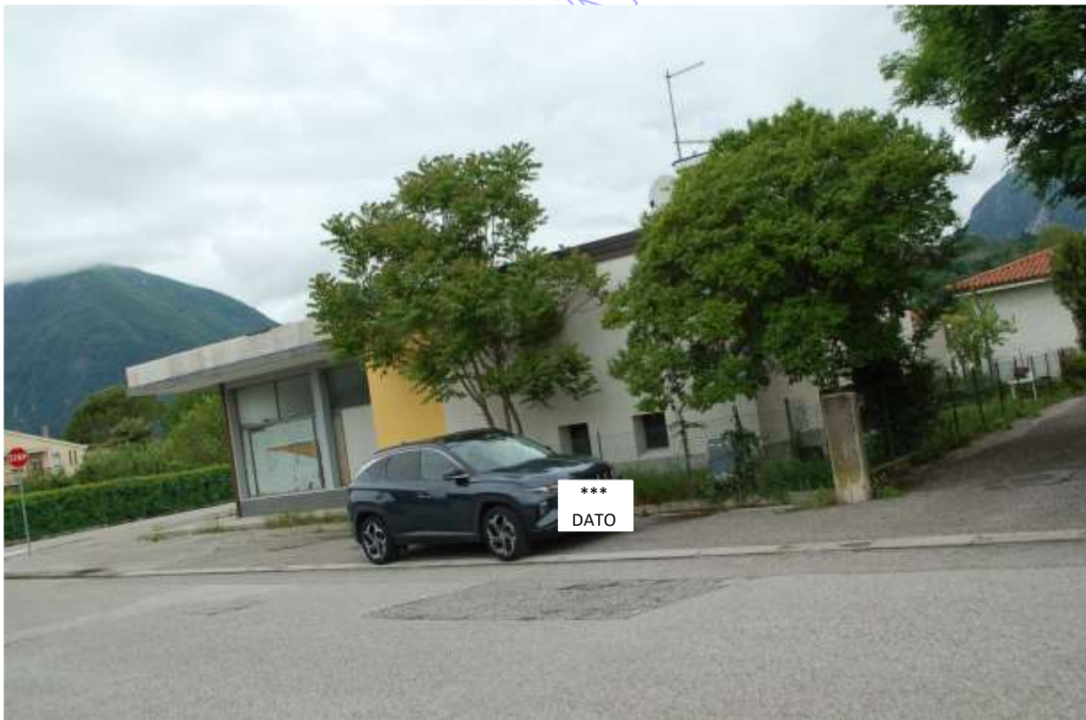
Vista lato via G. Garibaldi
